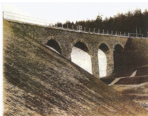
ŽELEZNIČNÍ VIADUKT U NĚMČIC V ROCE 1902
